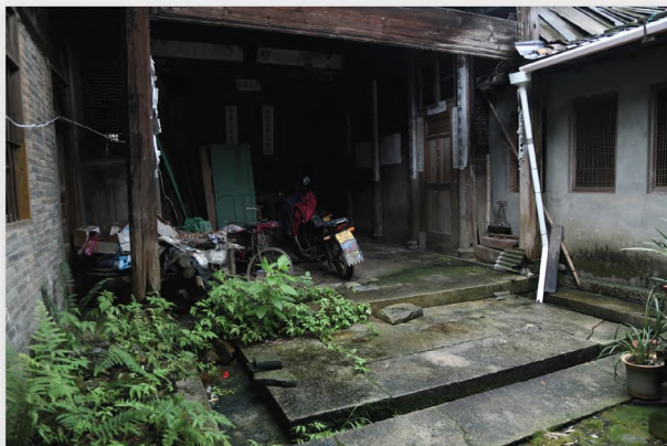
二进厅修缮前
